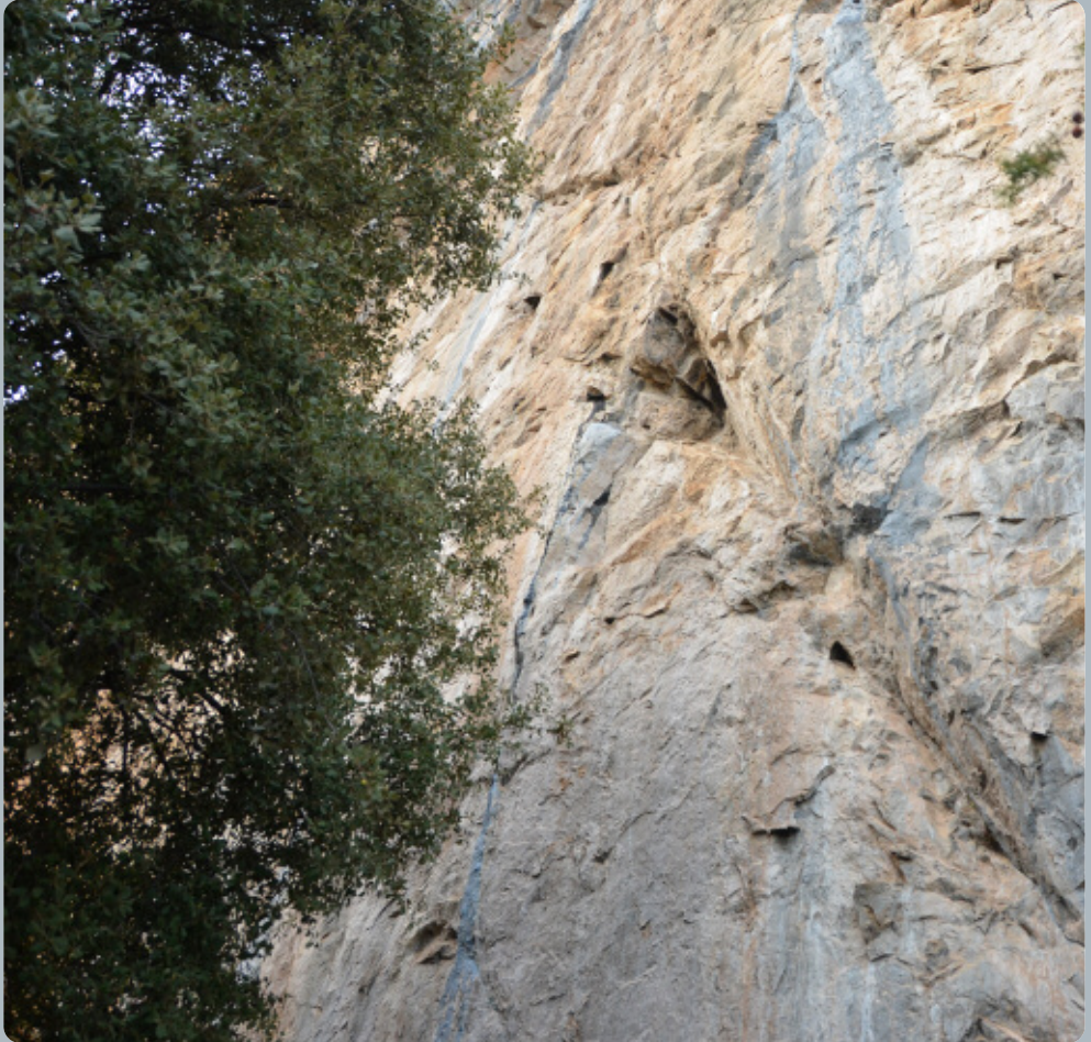
Fig.11. Detalle del eskarpe en el Corral de los Caballos, mostrando los planos de debilidad de la roca.
