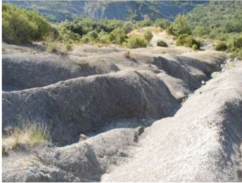
Imagen V: Zona de amplio acarcavamiento.
