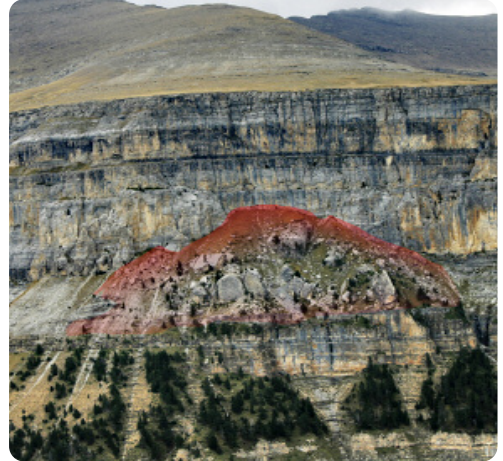
Fig. 14. En pared de enfrente, podemos observar un gran desprendimiento de bloques y derrubios (resaltado en rojo). Esto nos pone de manifiesto el alto grado de peligrosidad por inestabilidad de laderas en las zonas montañosas con vertientes escarpadas como en esta zona.
